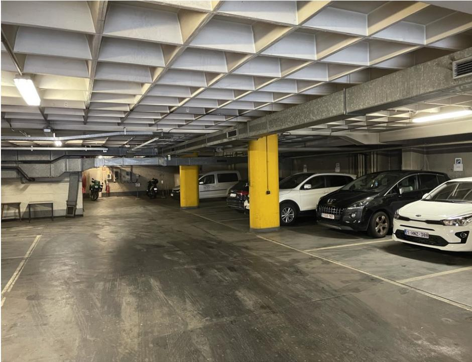
Le bâtiment est construit avec une structure en béton composée de poutres, de colonnes et de planchers à nervures.
